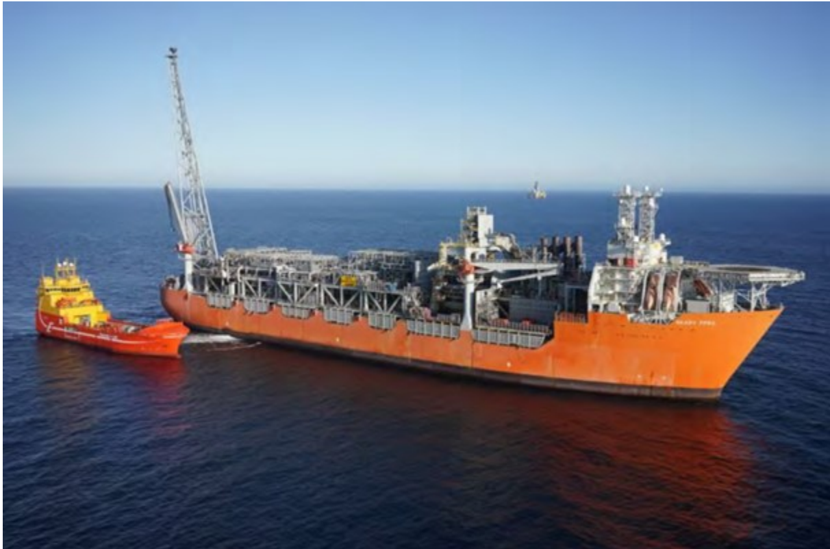
Fig. 3.5 Skarv FPSO. Kilde: Aker BP
